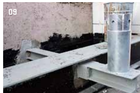
09 > Konzola pro točité schodiště, aby nepřetížilo původní strop
