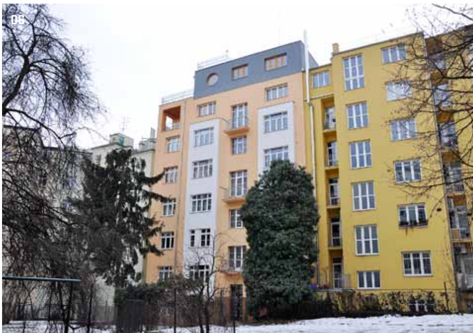
06 > Severovýchodní fasáda obrácená do zeleně vnitrobloku
