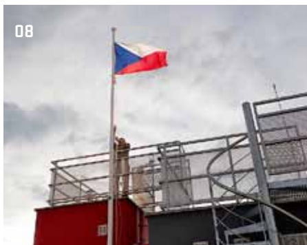
08 > Konstrukčním prodloužením výtahové šachty vznikl kapitánský můstek
