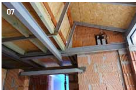
07 > Nosníky nejsou jen podpírané, ale i zavěšené
