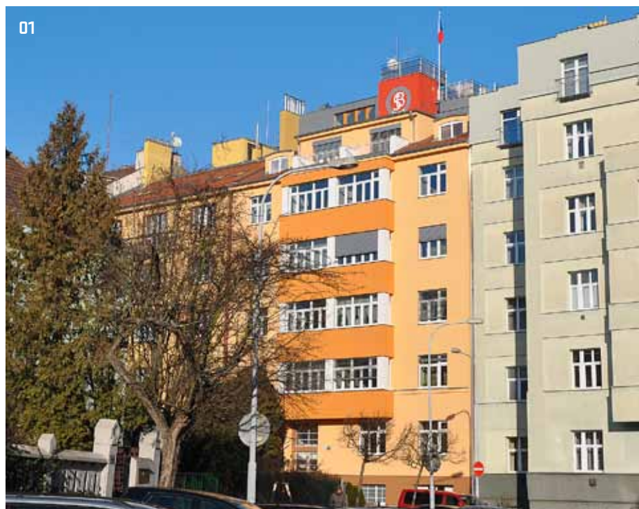
01 > Původní architektonické prvky domu zdůraznila barevnost zateplené fasády
